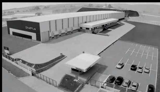
UNIDADE FABRIL Escada - PE
